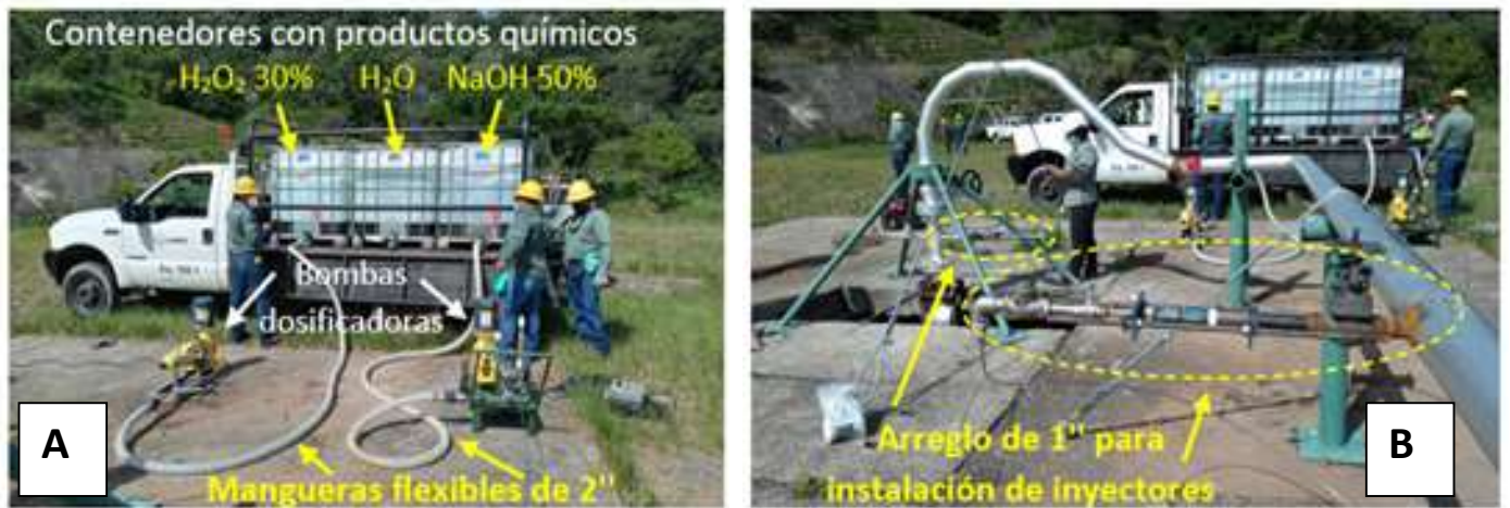
Figura 23: Purga de gases y neutralización de olores previo a la descarga del pozo TO-1A. Instalación de arreglos para conexión de a) bombas dosificadoras y b) inyectores de químicos.
