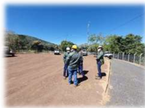
Figura 13: Supervisión ambiental para la adecuación de Plataforma TR-12 en CGB.
