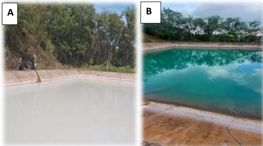
Figura 13: Agua Geotermia estancadas en piletas CHI3. A) muestra agua antes de separación de sílice (vista hacia el norte) y B) muestra agua después de separación se sílice (vista hacia el sur).
