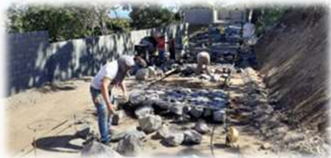
Empedrado en calle de acceso a terraza sistema contra incendio e Imprimación asfáltica
