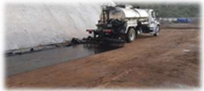
Empedrado en calle de acceso a terraza sistema contra incendio e Imprimación asfáltica
