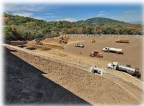
Figura 11: Supervisión ambiental durante obras civiles de Unidad de Ciclo Binario 2.
