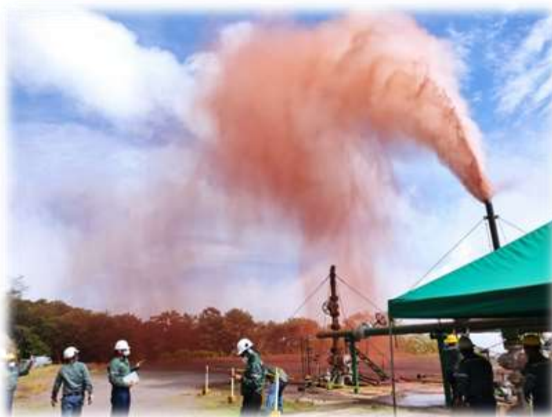
Figura 5: Monitoreo ambiental durante apertura de pozo CHI-3 en Campo Geotérmico de Chinameca.
