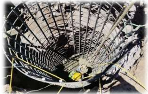
Obras de excavacion para fundacion de poste y Proceso de colocacion de concreto hidraulico en fundacion.
