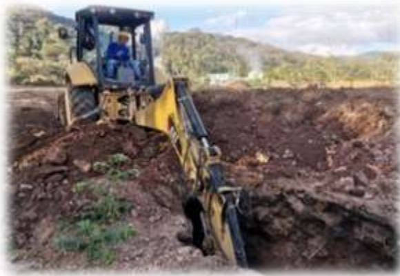
Obras de excavacion para fundacion de poste y Proceso de colocacion de concreto hidraulico en fundacion.
