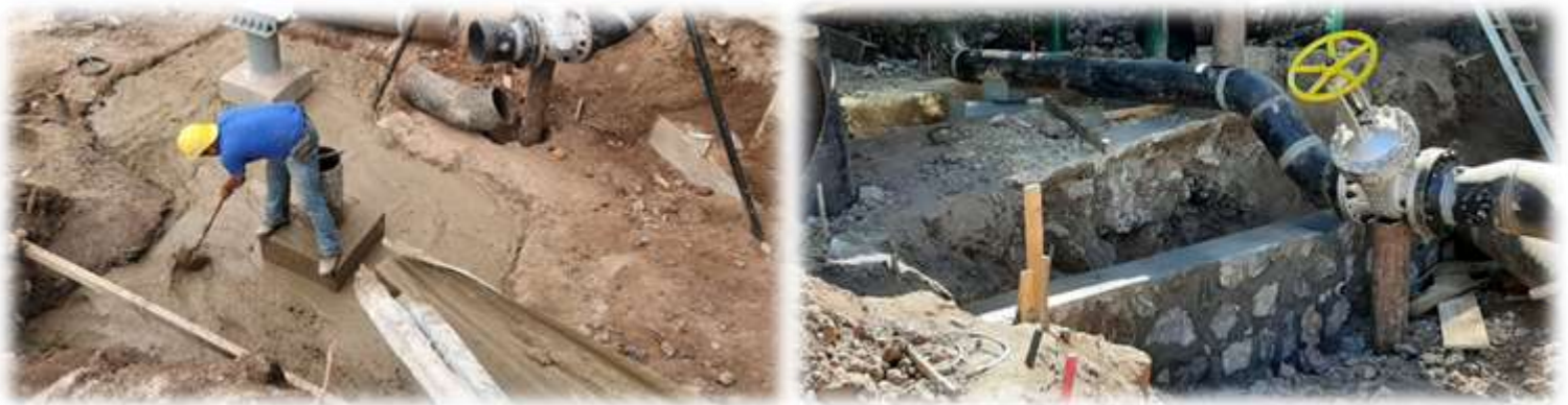
Relleno de estructura con suelo cemento fluido.
