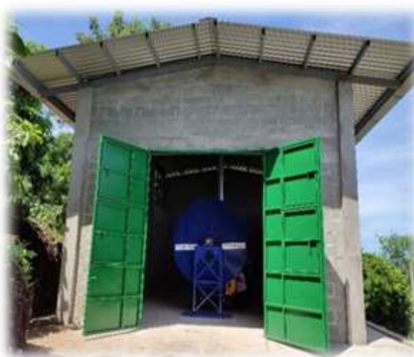
Figura 1. Bodega construida en el proyecto SECABE ubicado en la finca San Ramón, Berlín, Usulután.
