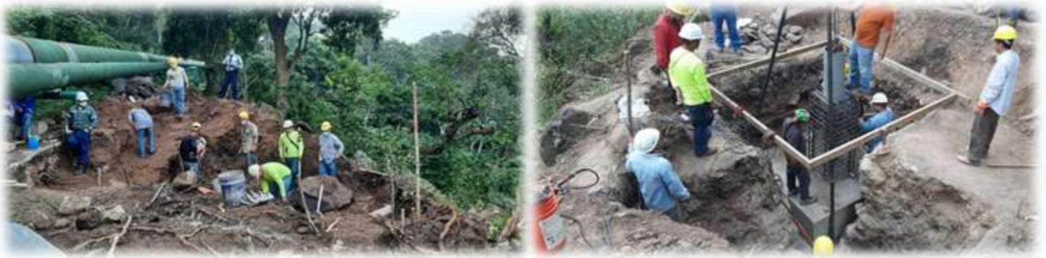
Excavación para terraza y estructura proyectada
