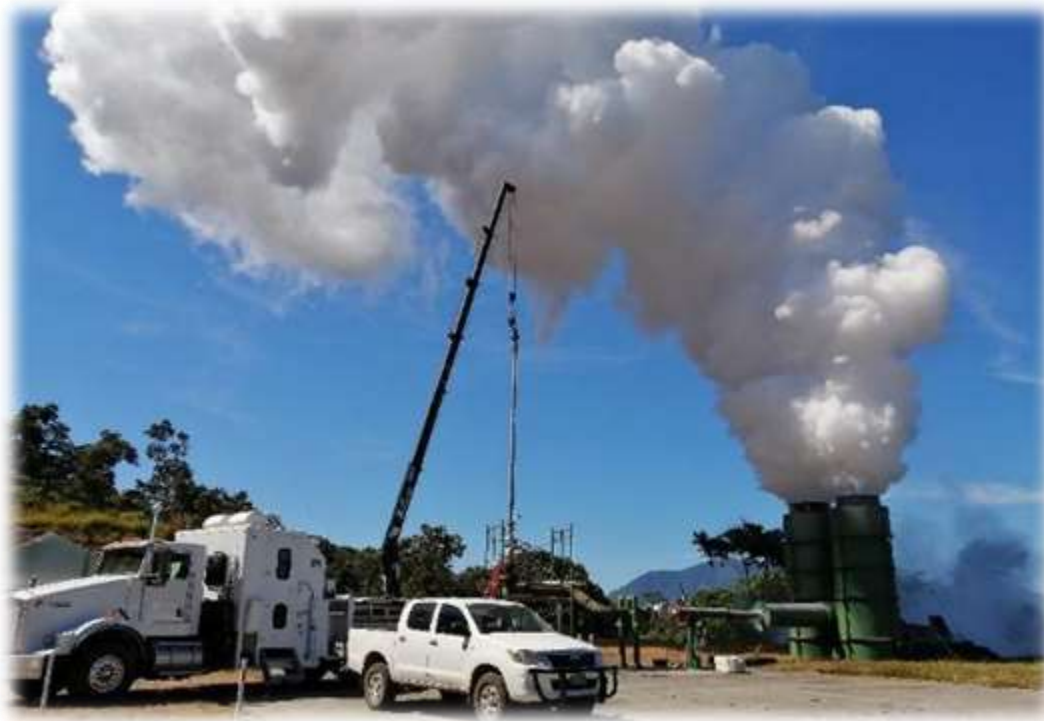
Figura 22: Descarga Pozo CHI-6A en noviembre de 2021
