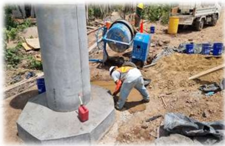
Acabado final de fundacion de poste
