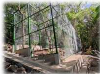
Figura 15: Supervisión de construcción de recinto de aves rapaces en CGB.
