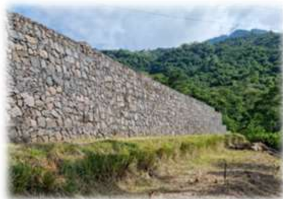
Vista de muro gavión en Sitio de Disposición Final.
