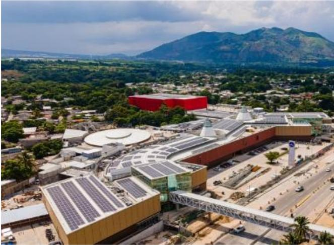
El diseño del centro comercial tiene recursos para reducir los impactos negativos en el medio ambiente, entre estos: sistemas de reciclaje de agua lluvia para utilizarla en los servicios básicos, creación de una planta fotovoltaica de 2,000 paneles solares, que permitirá un ahorro estimado del 20% en la factura energética.
