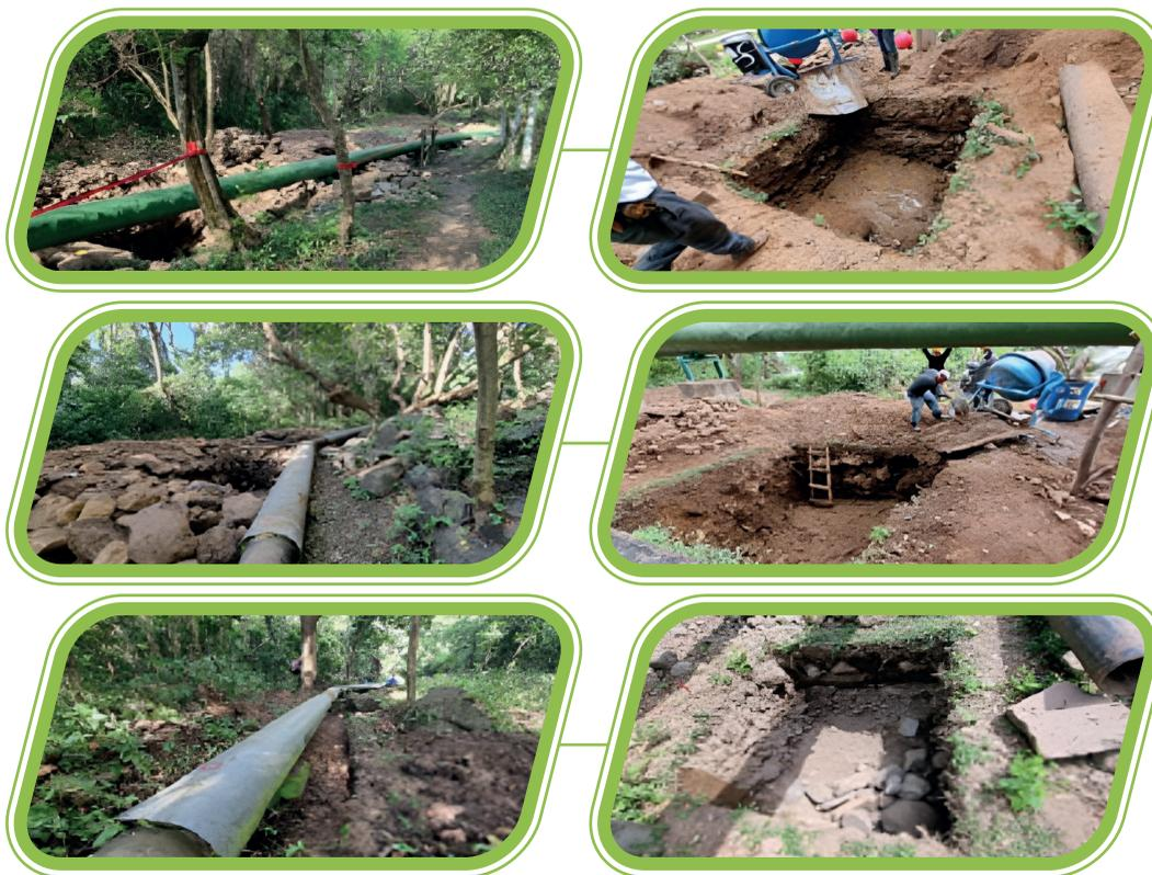
Construcción de obras civiles y mecánicas para el montaje de línea de reinyección en frío, desde la Central Geotérmica Ahuachapán hasta el pozo AH-2R
